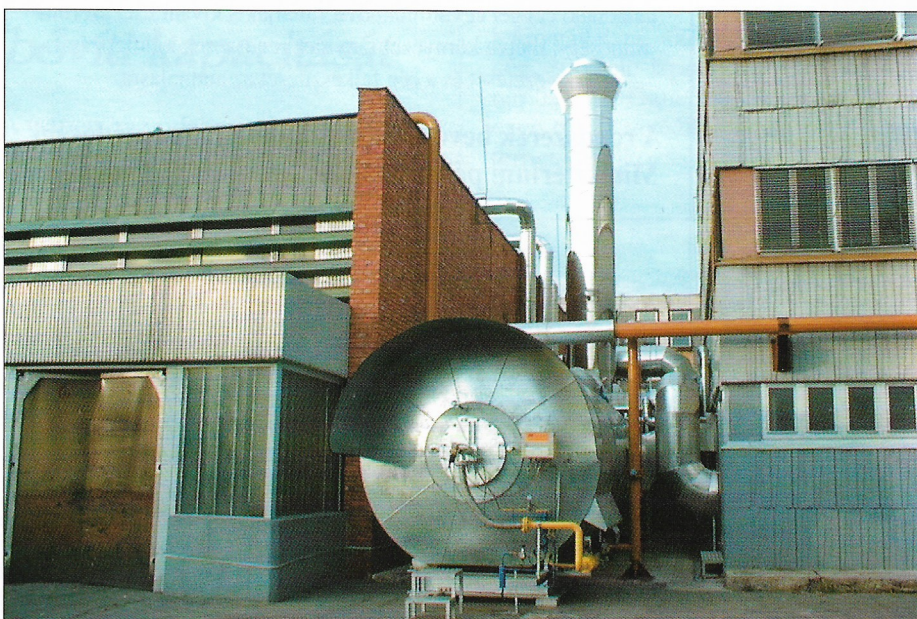
A WK TNV utánégető berendezés az Alföldi Nyomdában
